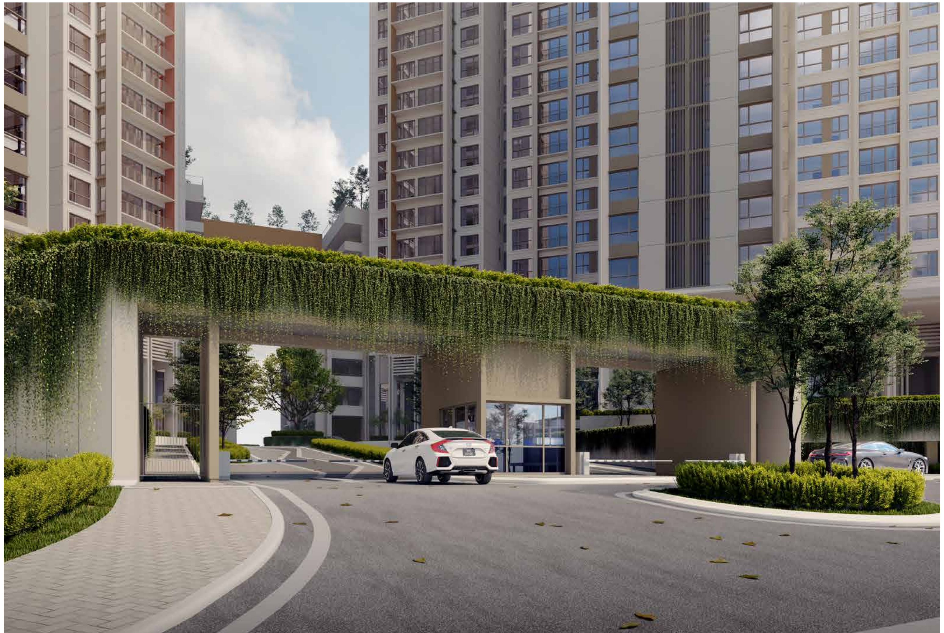
PANDANGAN PINTU MASUK UTAMA
