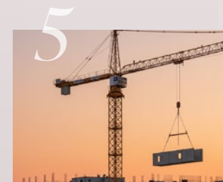
Pemasangan dengan Kren
