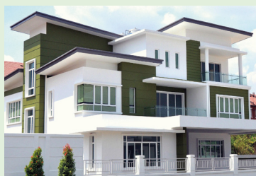
TAMAN TAMING MUTIARA 2 @ BDR.SUNGLAI LONG 41 unit Fasa 1 Rumah Banglo 3 Tingkat Slap 2013; 36 unit Fasa 2 Rumah Banglo 3 Tingkat Slap 2015
