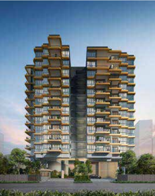
MYRA (SEDANG DIBANGUNKAN)
