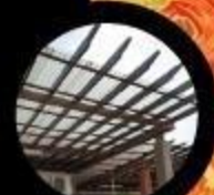
Lantai Anjung Kereta Bercorak Terracota & Berkayu Pergola
